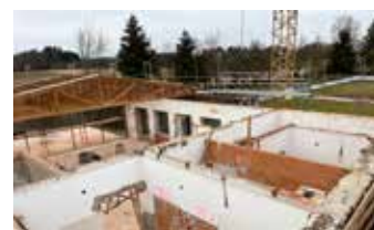
Ende des Rückbaus
