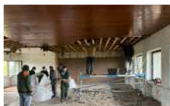
Rückbau des Gastraums
